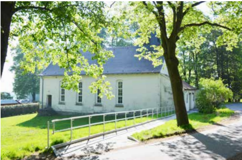
Die Kapelle Zug hat jetzt einen barrierefreien Zugangsweg
